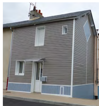
La pose de bardages PVC qui dissimule les encadrements de baies et les corniches, rigidifie la façades et empêche les murs de respirer
