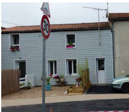
La pose de bardages PVC qui dissimule les encadrements de baies et les corniches, rigidifie la façades et empêche les murs de respirer
