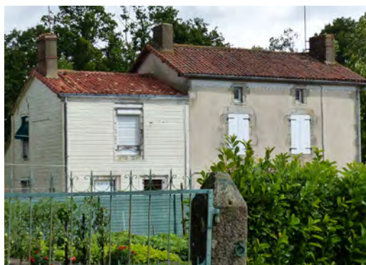
La pose de bardages PVC qui dissimule les encadrements de baies et les corniches, rigidifie la façades et empêche les murs de respirer
