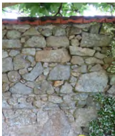
Mur en moellons de granite
