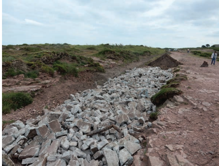
Le réemploi des produits de démolition
