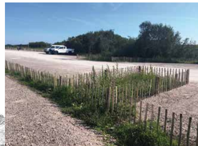
Le stationnement en retrait est traité avec sobriété avec des noues et des ganivelles pour dessiner les places de stationnement. (Unité littorale de la Baie de Saint-Brieuc et caps d'Erquy-Fréhel, Bretagne)
