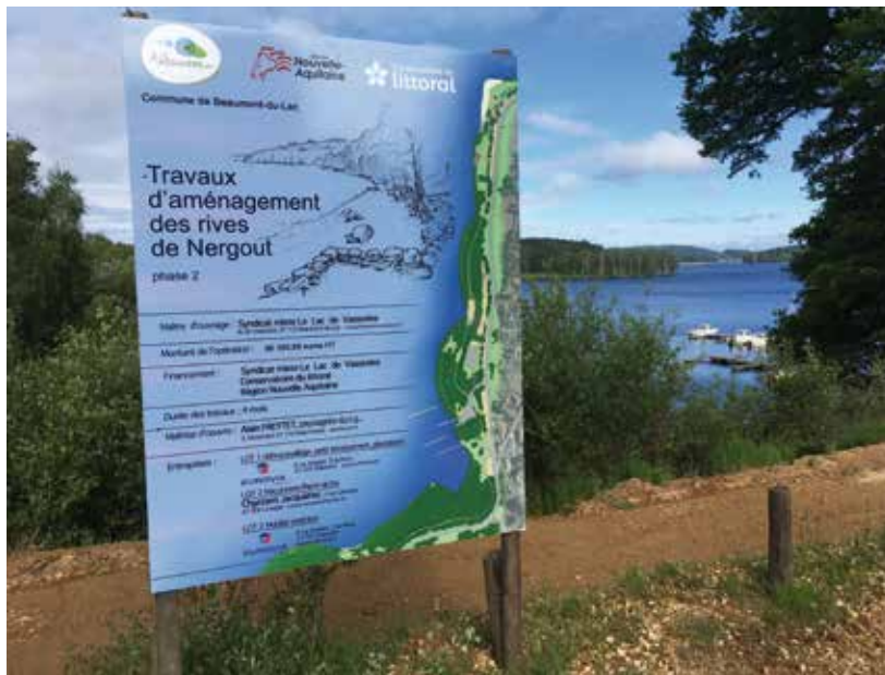
Sur la parcelle du Conservatoire en bord de lac, les travaux d'ouverture d'un sentier pédestre de bord de rive et d'un chemin cyclable passant plus haut sont en cours. (Unité littorale du lac de Vassivière, Grands Lacs)
